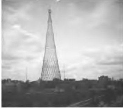
Рис. 4. Шуховская башня на Шаболовке, г. Москва
