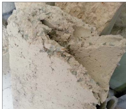
Рис. 3. Стеновой бетонный блок после разрушения
